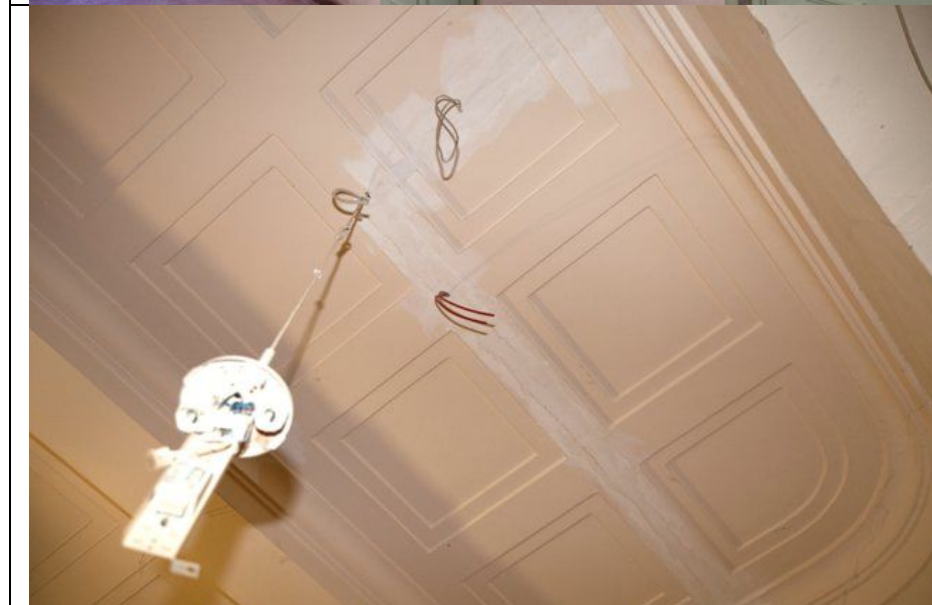
Deckenbereich nach Kabelzug
